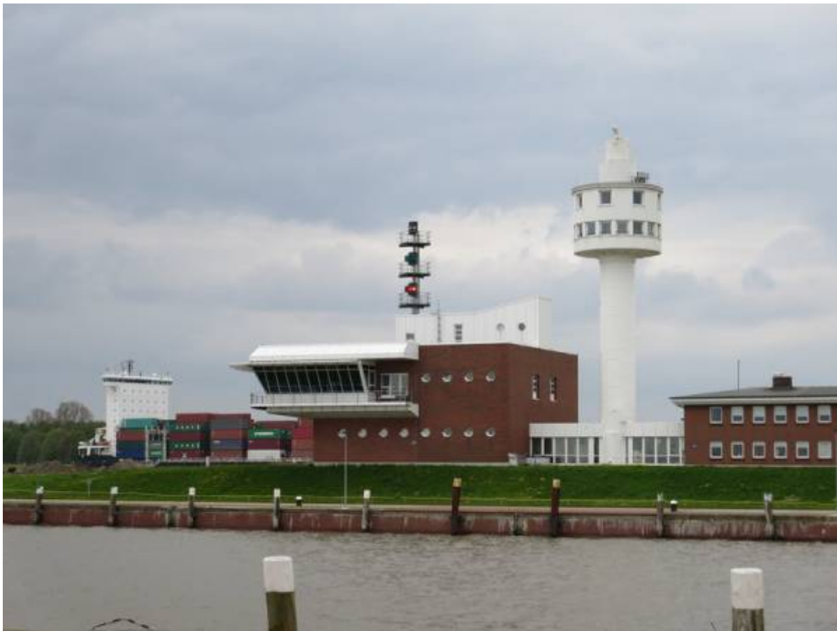
Schleuse zum NOK...
