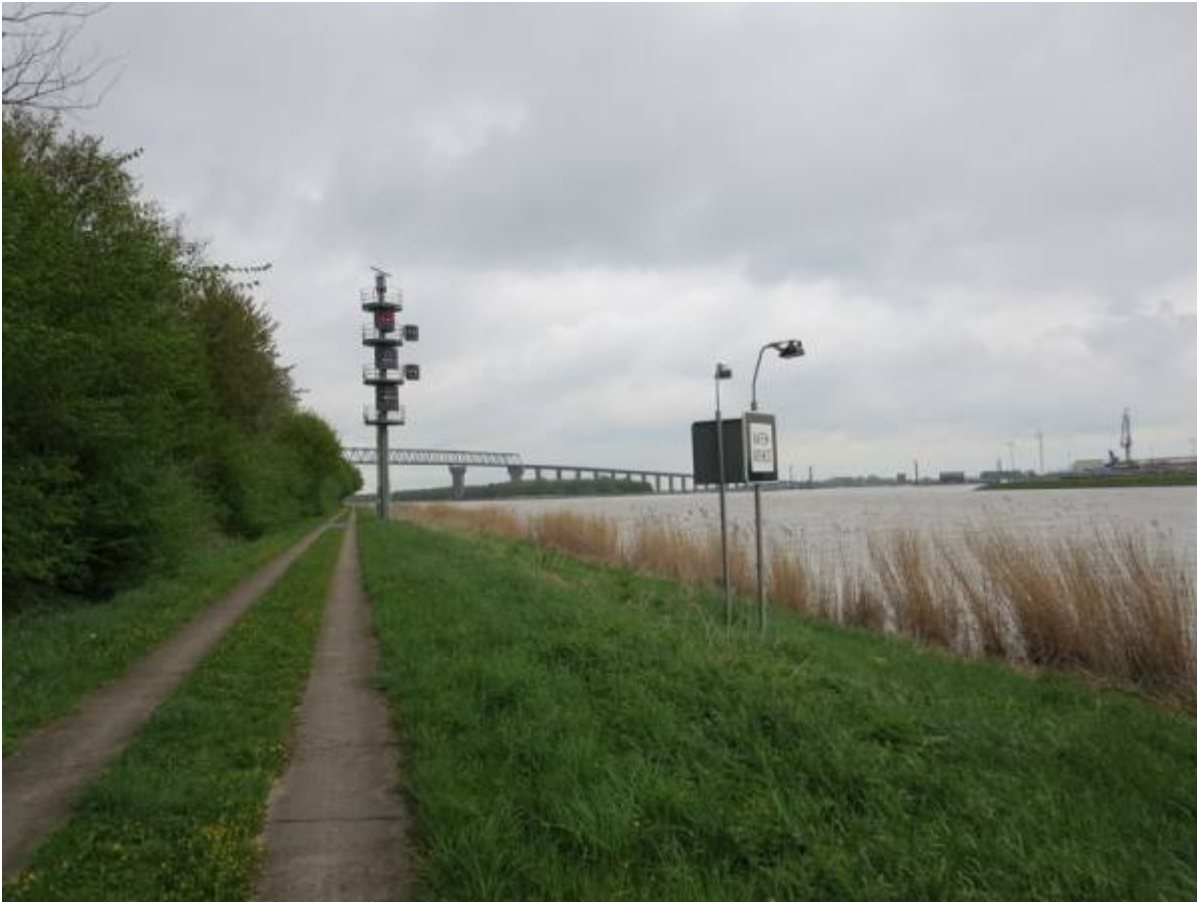
Eine Autobahnbrücke über den NOK
