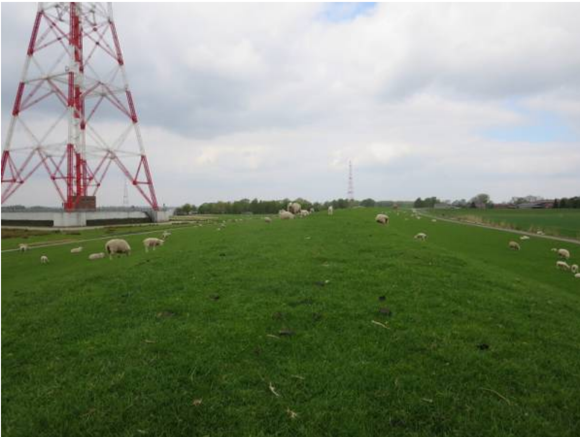
Schafe an der Elbe. Der Strommast ist riesig: das dicke Rohr in der Mitte ist eine Wendeltreppe...
