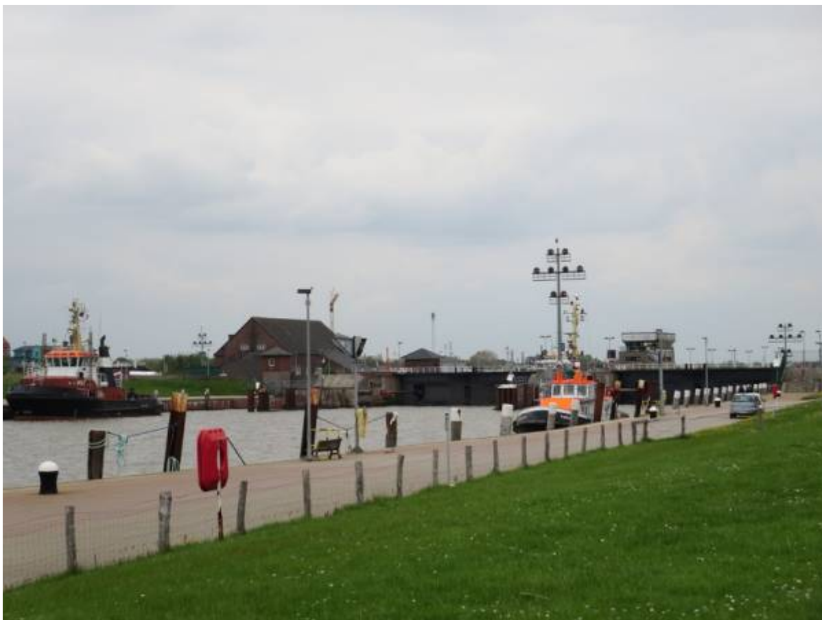
Schleuse zum NOK...
